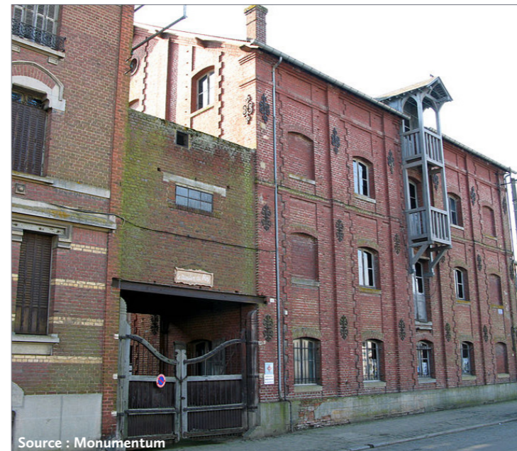
6 - Ancienne Minoterie Lambotte à Aumale Cette minoterie à meule est construite vers 1850. L'établissement fonctionne jusqu'en 1970. Subsistent aujourd'hui la totalité du bâtiment, en brique à armature métallique, et l'ensemble des machines.
